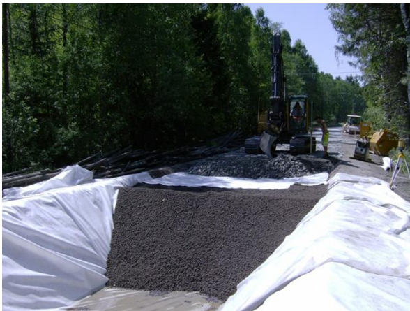
Figur 9. Svepning av lättklinker med nålfiltad geotextil
