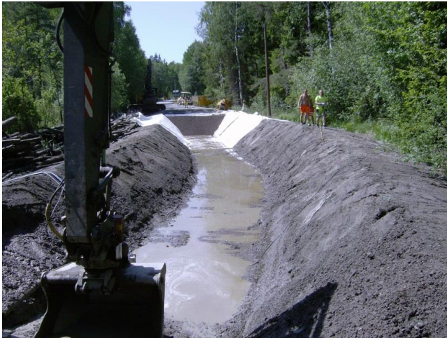
Figur 8. Schakt och återfyllning
